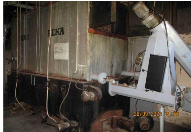
Fotod 6. Vana-Antsla katlamaja (esikülg ja tagant hakkepuidupunker ning sissesead)
